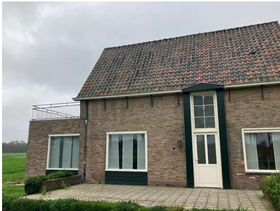
• Afbeelding 4: voorgevel woonhuis
