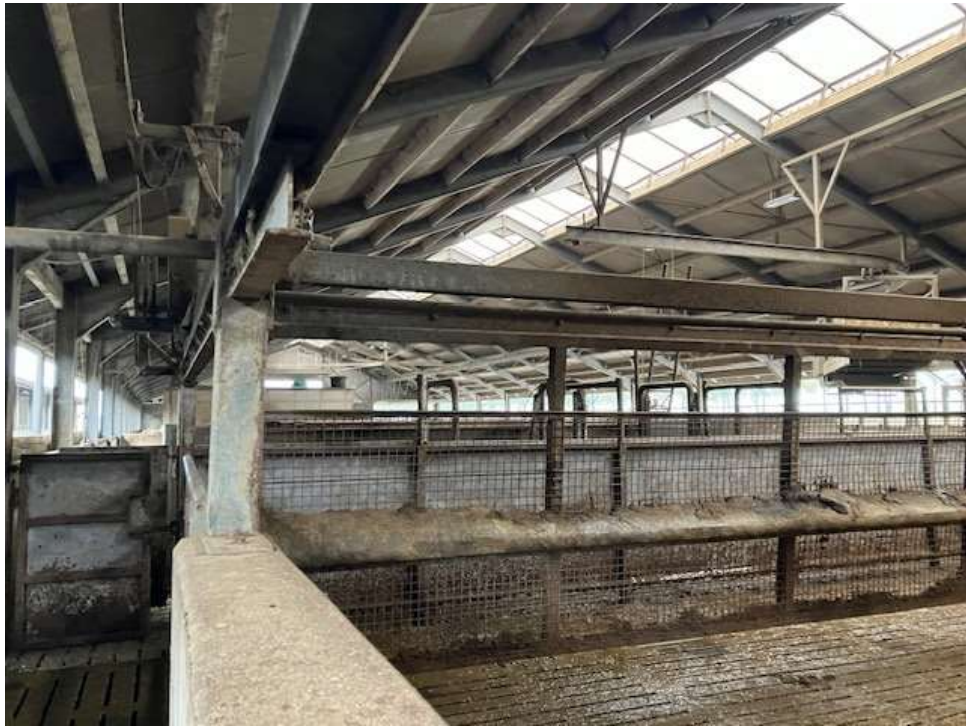
• Afbeelding 23: binnenzijde stal 1 (wachtruimte)
