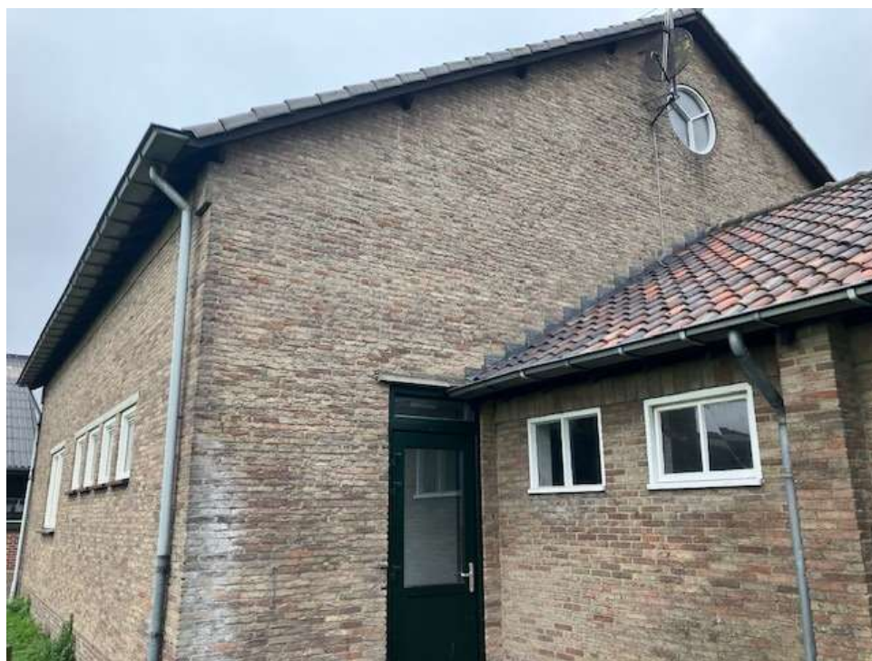
• Afbeelding 9: te behouden schuur (links), rechter schuur wordt gesloopt
