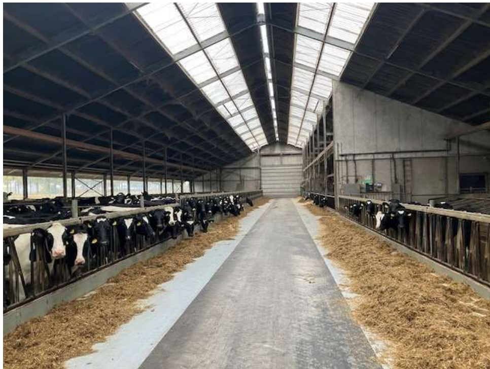
• Afbeelding 26: binnenzijde stal 4, ongeïsoleerde golfplaten met licht doorlatende golfplaten
