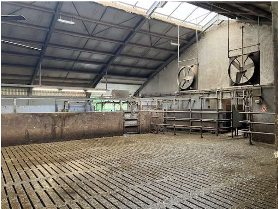
• Afbeelding 24: binnenzijde stal 1 (wachtruimte)
