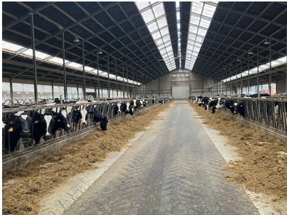
• Afbeelding 21: binnenzijde stal 3, ongeïsoleerd dak met lichtstraat en licht doorlatende golfplaten
