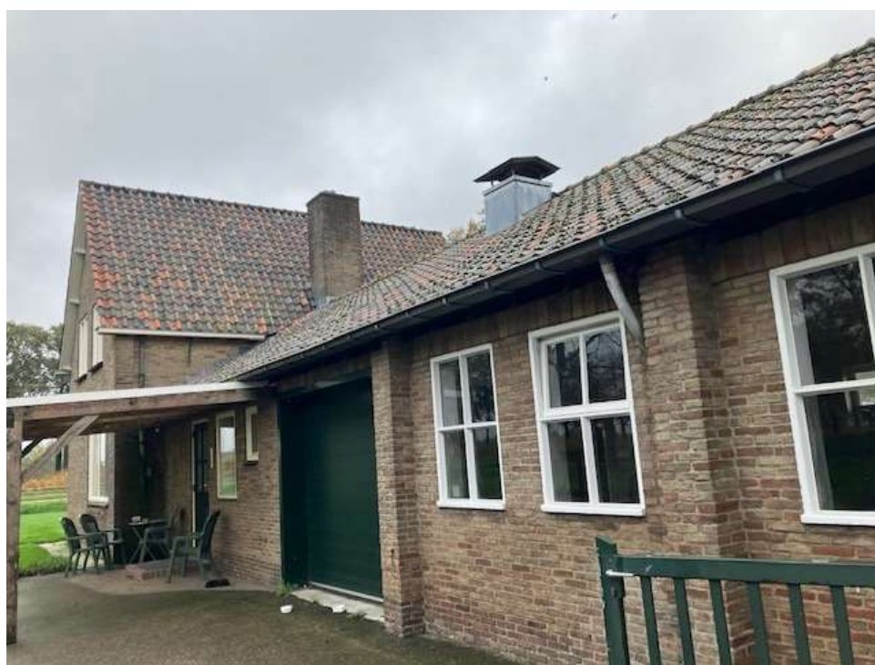
• Afbeelding 10: rechter zijgevel te slopen schuur met daarachter de te slopen woning
