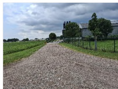
Figuur 2.5. Toegangsweg naar de boerderij ten westen van de onderzoekslocatie, kijkrichting zuid.
