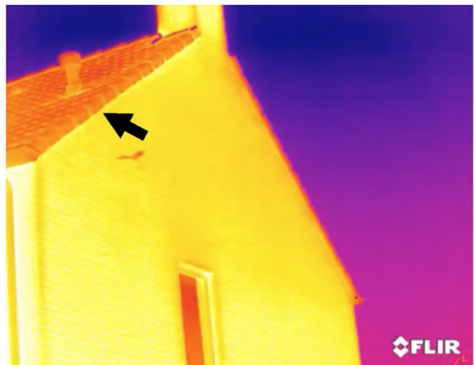
afb. 3b. Aanvliegende Laatvlieger 1 die vervolgens onder gevelpan kruipt, Ospelseweg 3 (foto warmtebeeldcamera)
