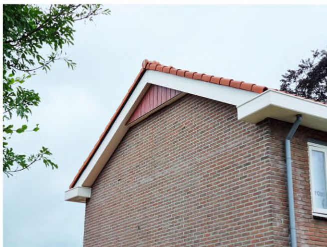
afb. 10c. Speciale Laatvliegerkast VMN1 (van Unitura)
