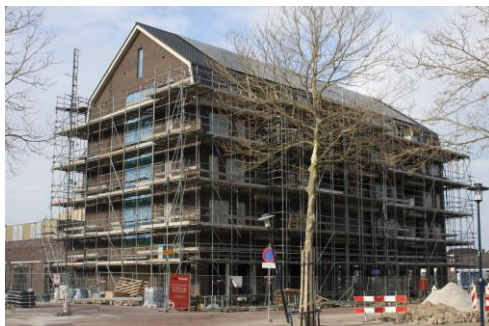
Appartementen in aanbouw centrumplan Nederweert
