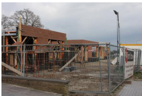
Seniorenwoningen in aanbouw, Nederweert-Eind
